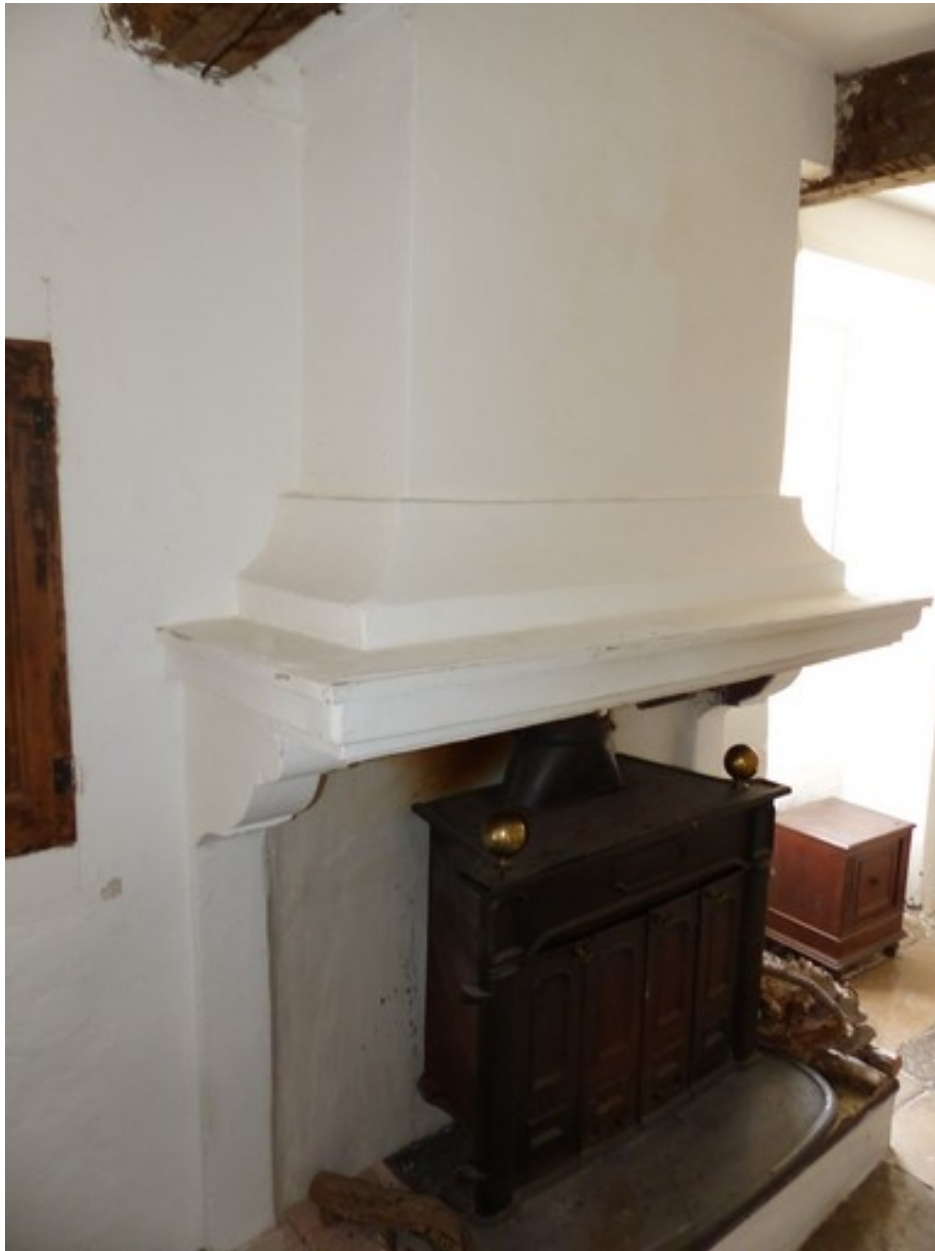
Bâtiment principal. Troisième étage de soubassement, cuisine. Mur sud, cheminée.
