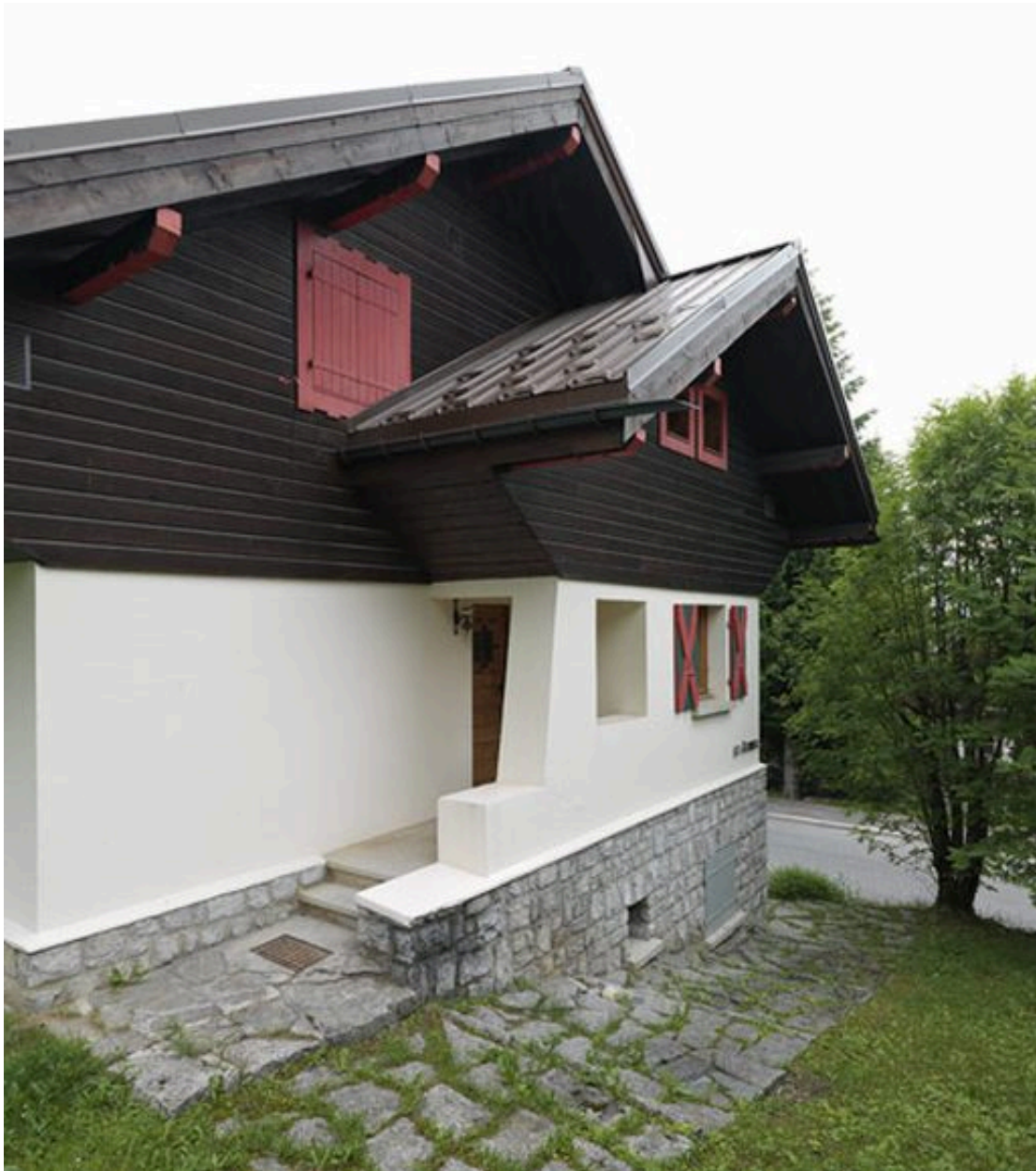
Chalet les Sorbiers, 373 route du Bouchet, construit en 1950
