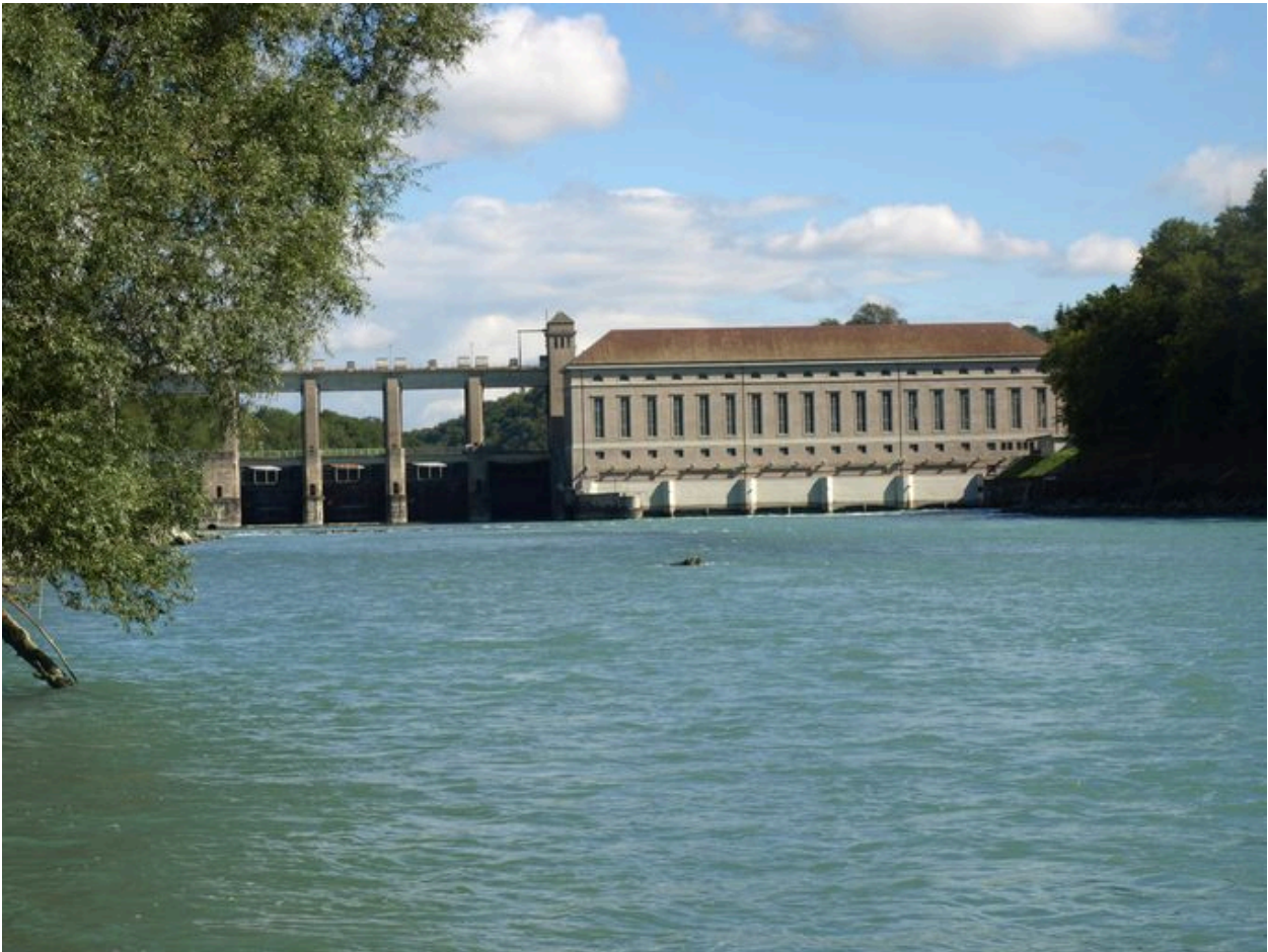
Vue générale rapprochée, face aval (depuis la rive droite)
