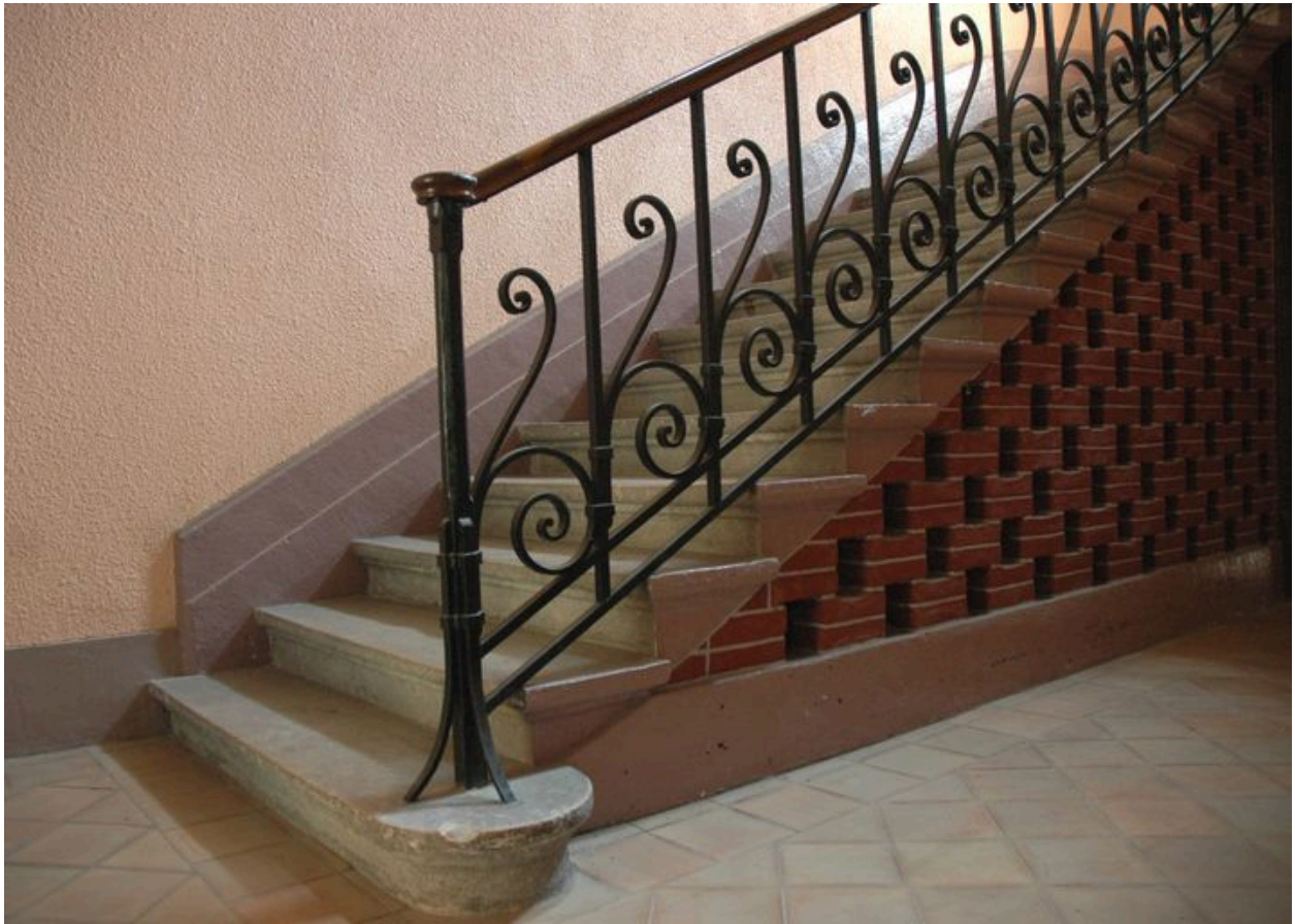
Escalier sud, première volée, détail du claustra
