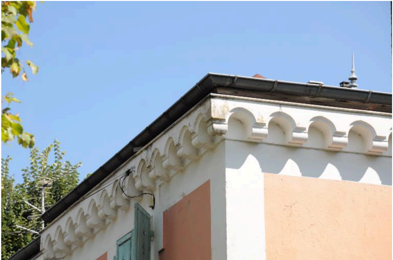
Détail sur la corniche en arcature et à modillons
