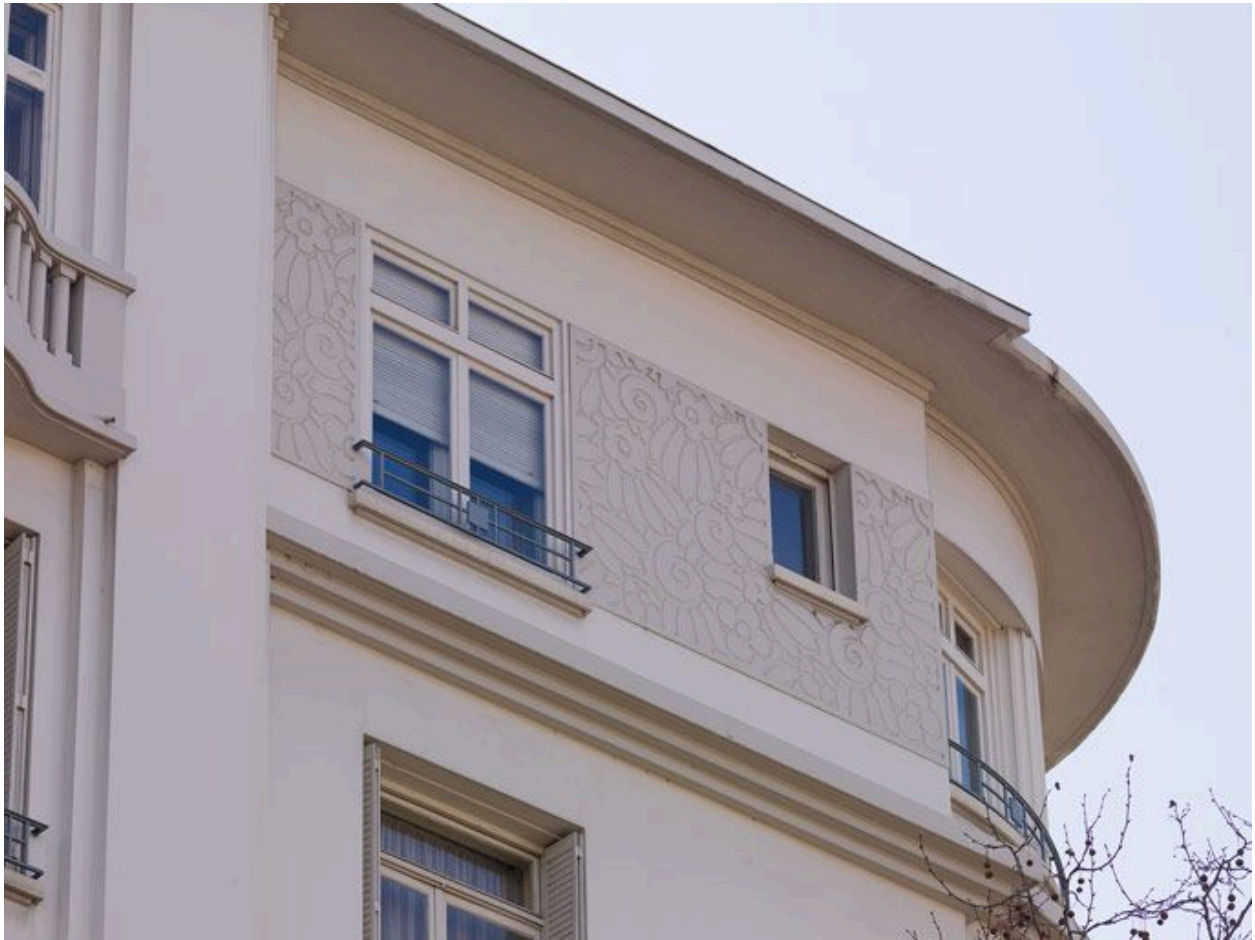
Détail du dernier étage, angle de la rue Pierre-Robin
