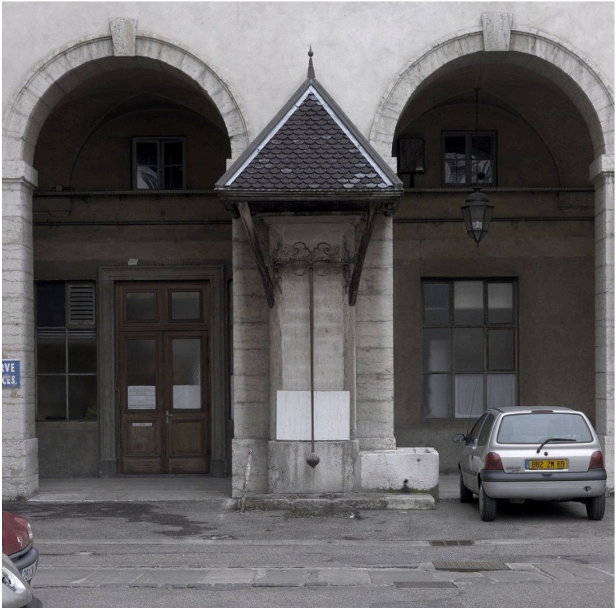
Le puits de la cour de la Chaufferie
