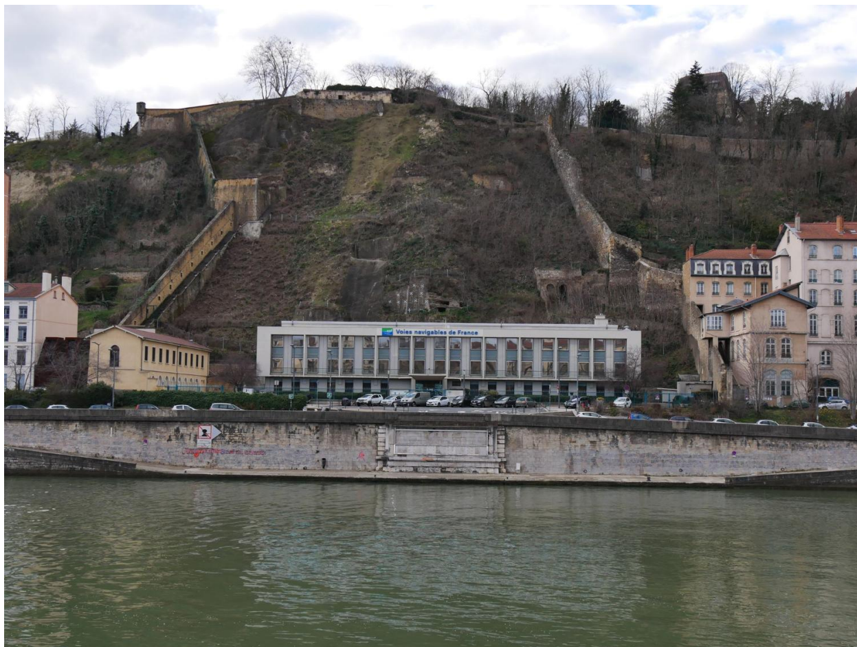
Bureaux VNF, Voies Navigables de France , vue est
