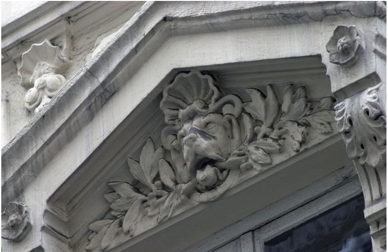
Façade rue Longue, 1er étage, détail de la 13e fenêtre en partant de la gauche
