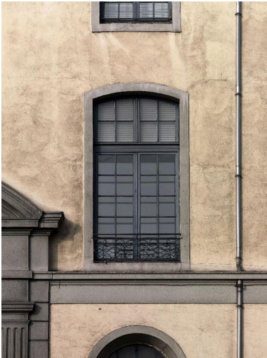
Elévation postérieure, 1er étage, détail d'une baie
