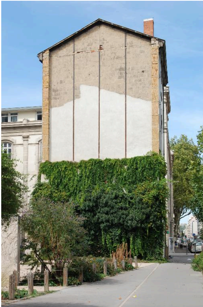
Vue de l'élévation sud mise à nu par la démolition des bâtiments adjacents
