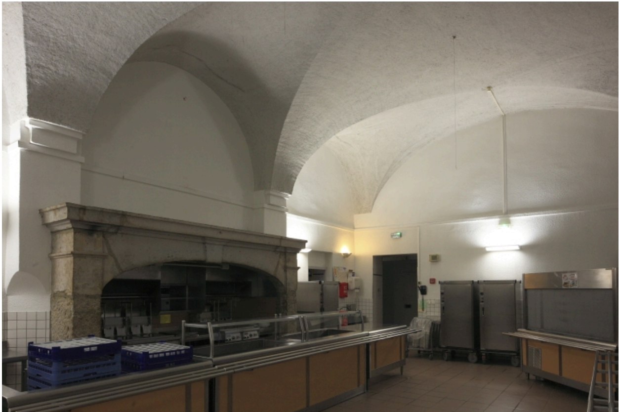
Bâtiment C. Rez-de-chaussée, la cuisine : cheminée monumentale, salle couverte de voûtes d'arêtes.
