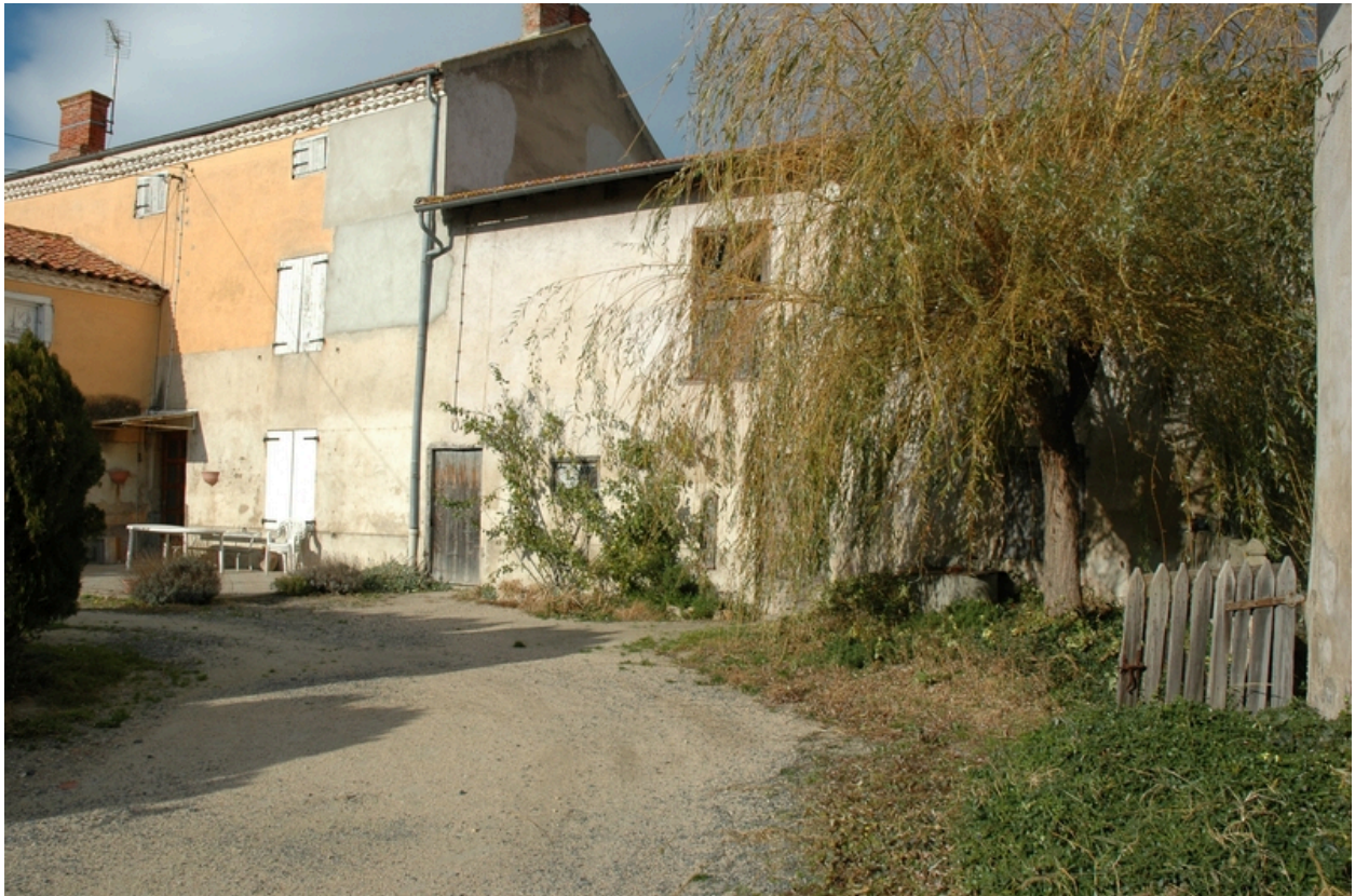
Vue intérieure de la cour, depuis le sud : logis, écurie (?).
