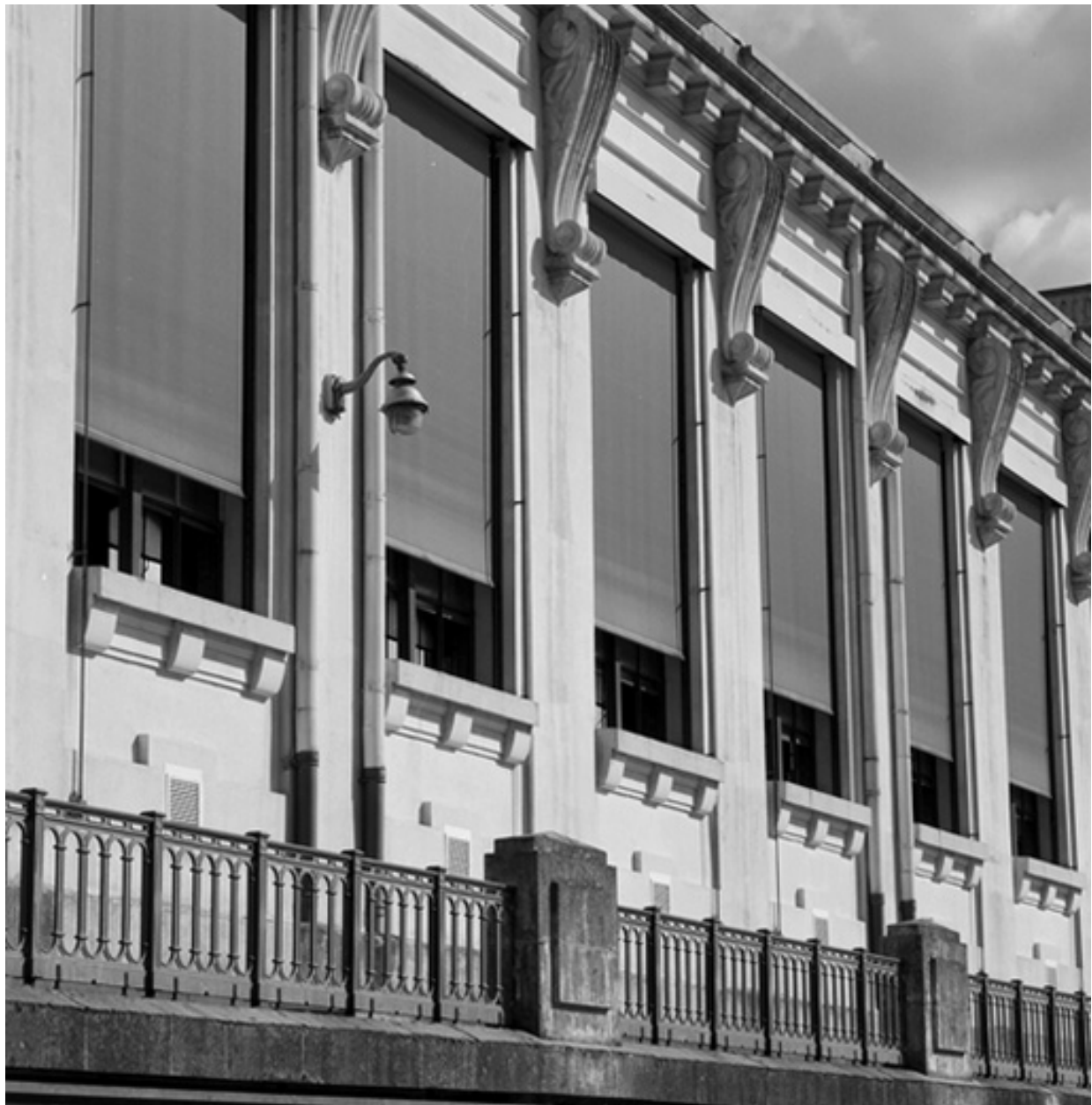
Détail façade aval
