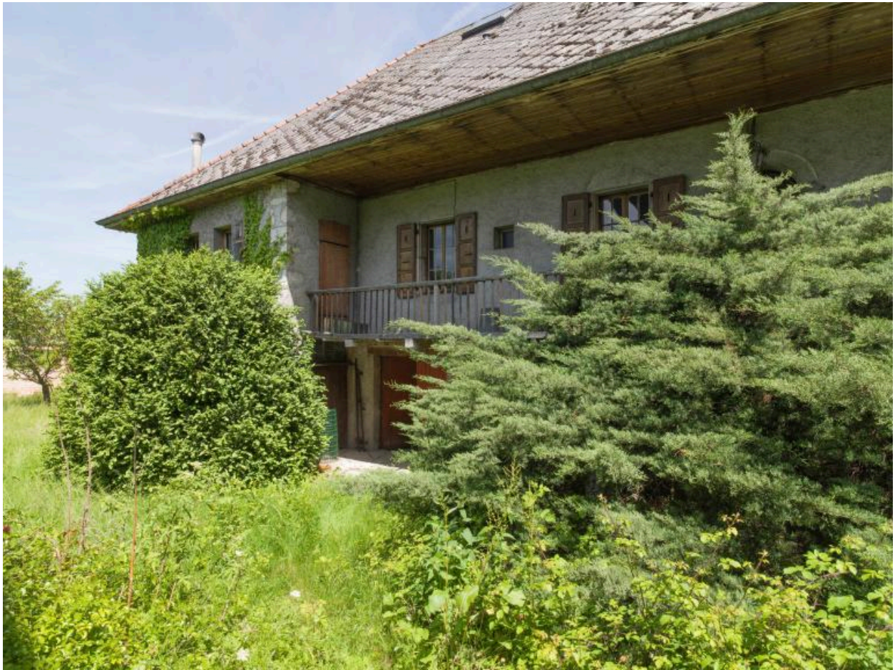
Détail de l'étage de soubassement, façade latérale gauche.
