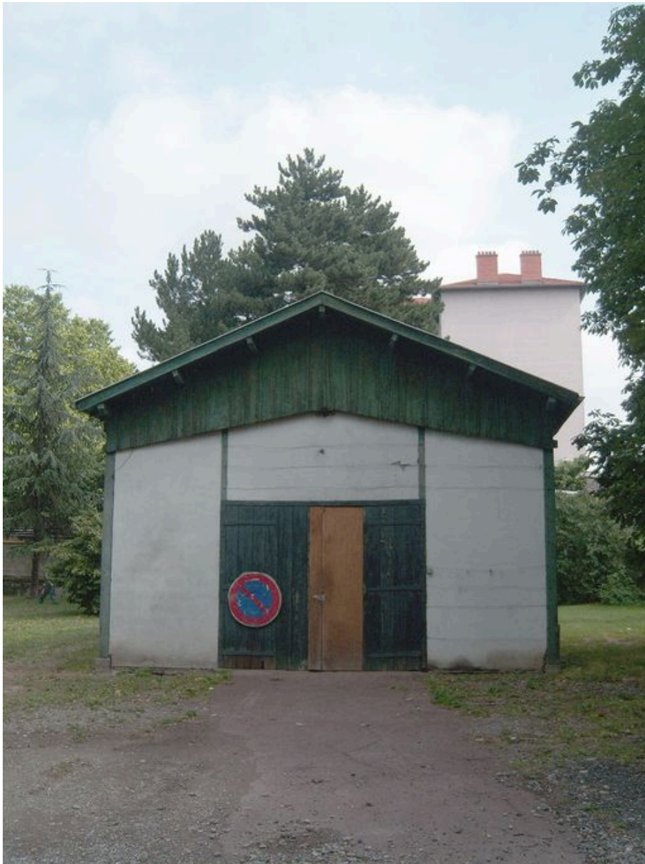
Bâtiment Nord Est, côté rue de Gerland, élévation Sud
