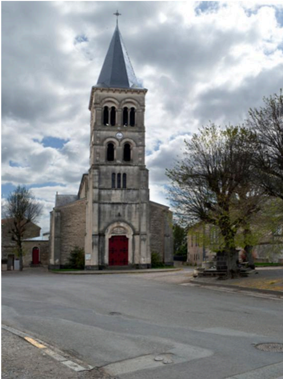
Vue générale de la façade occidentale.
