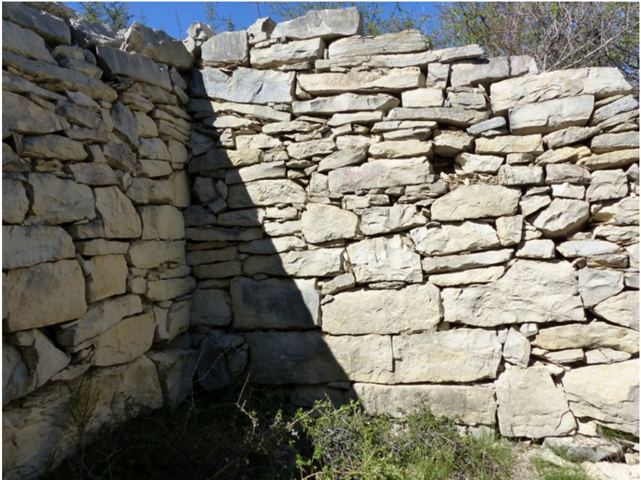
Maçonnerie en pierre sèche d'une bergerie. Quartier de Souvechanne.
