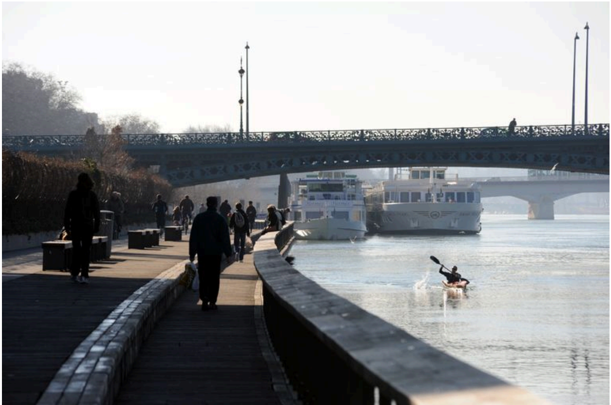
Arche gauche, face amont, vue partielle : passage du quai (depuis la rive gauche)
