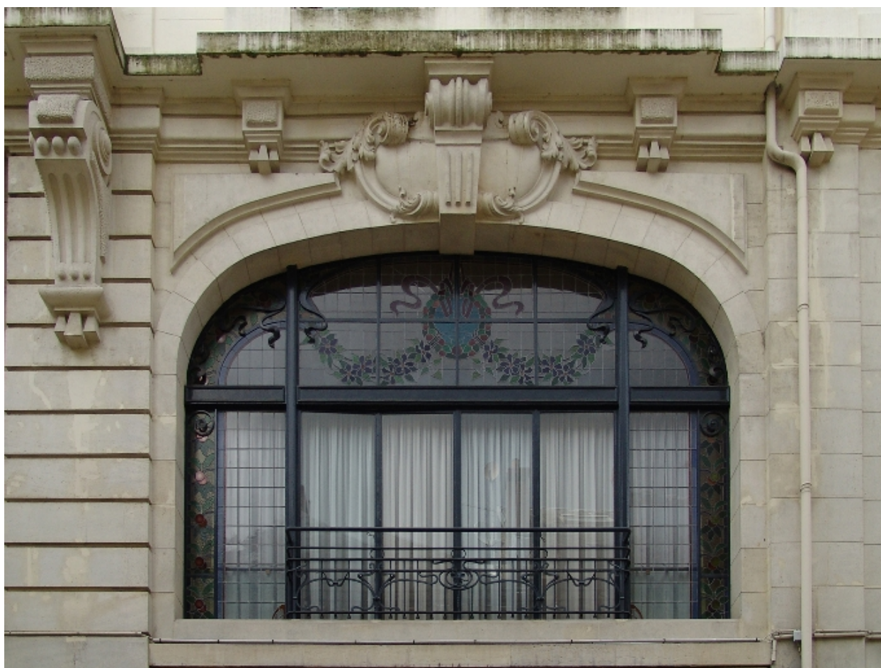
Détail d'une baie sud avec verrière
