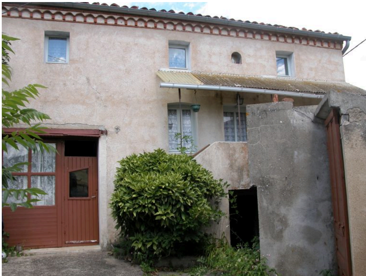
Quérézieux (1986 AM 63). Ferme, vue d'ensemble façade.
