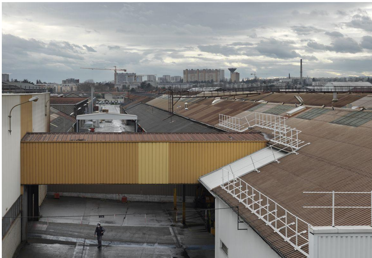
Vue des toitures
