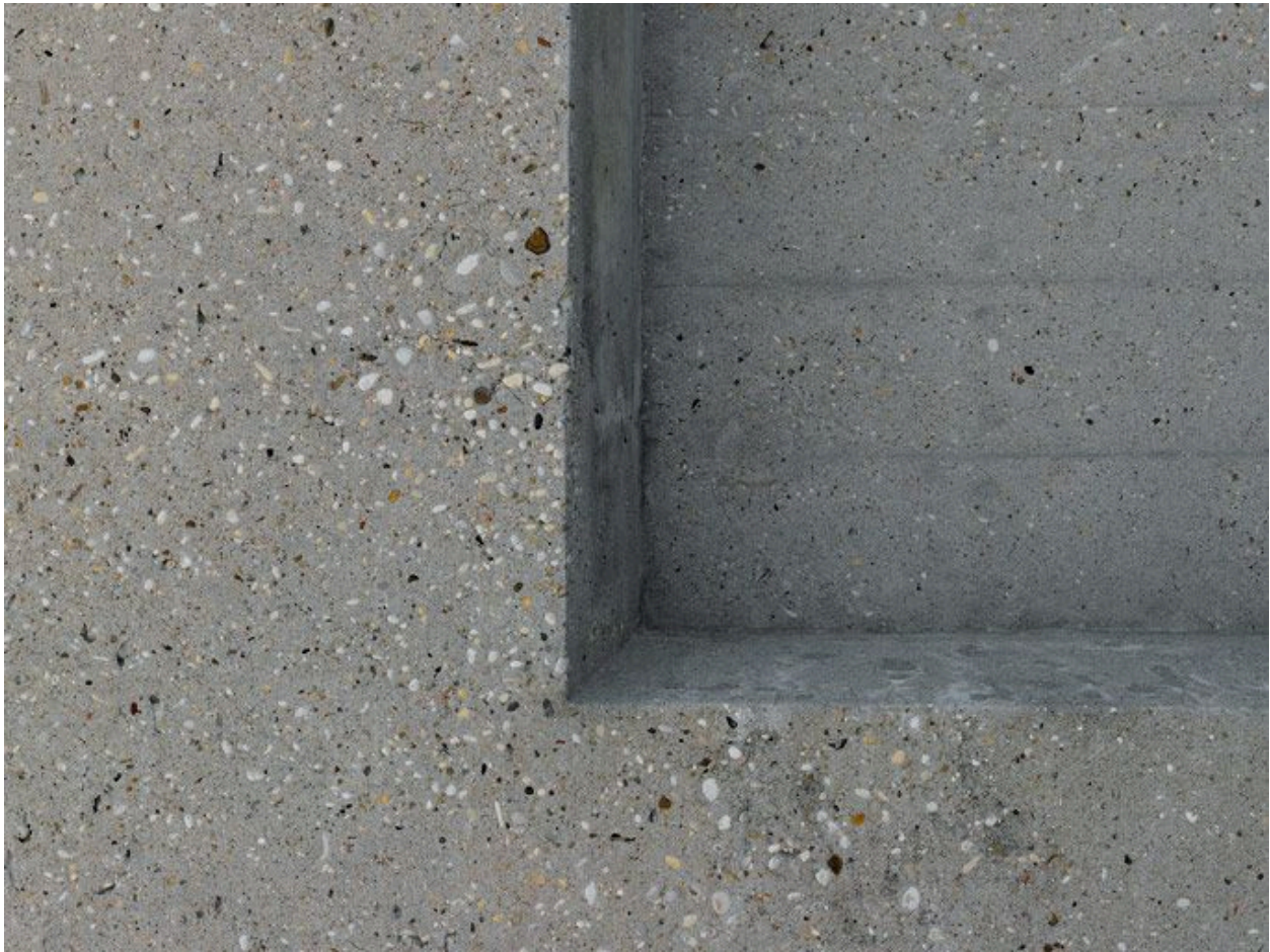
Détail de la mise en oeuvre du béton (paroi nord).
