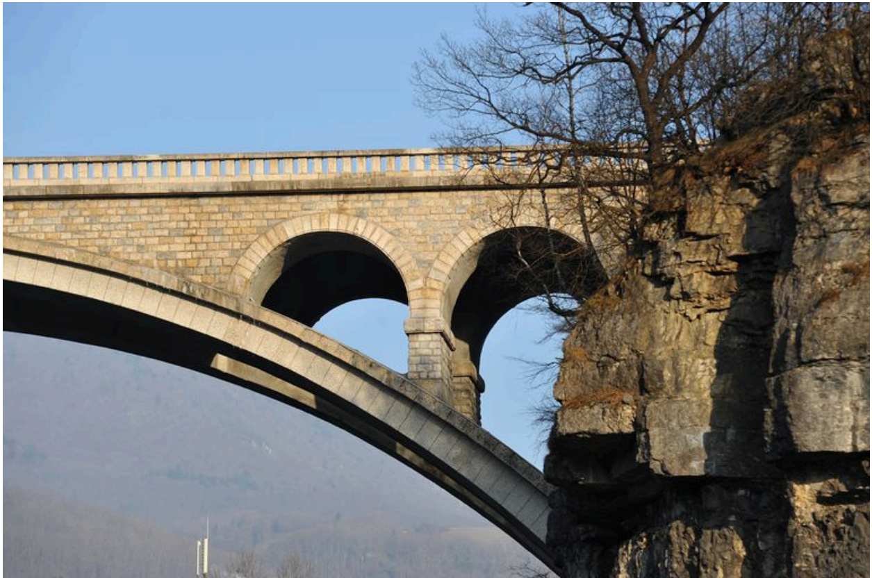
Partie gauche de l'arche centrale, face aval, vue de détail : petites arches
