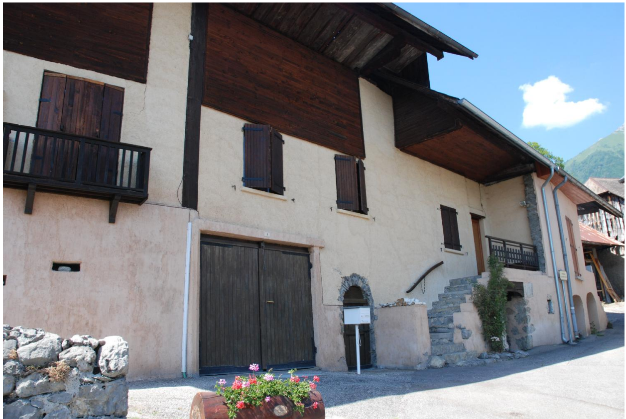
Maisons de vigneron (les Allues-dessous, 2018 YE 114, 113).
