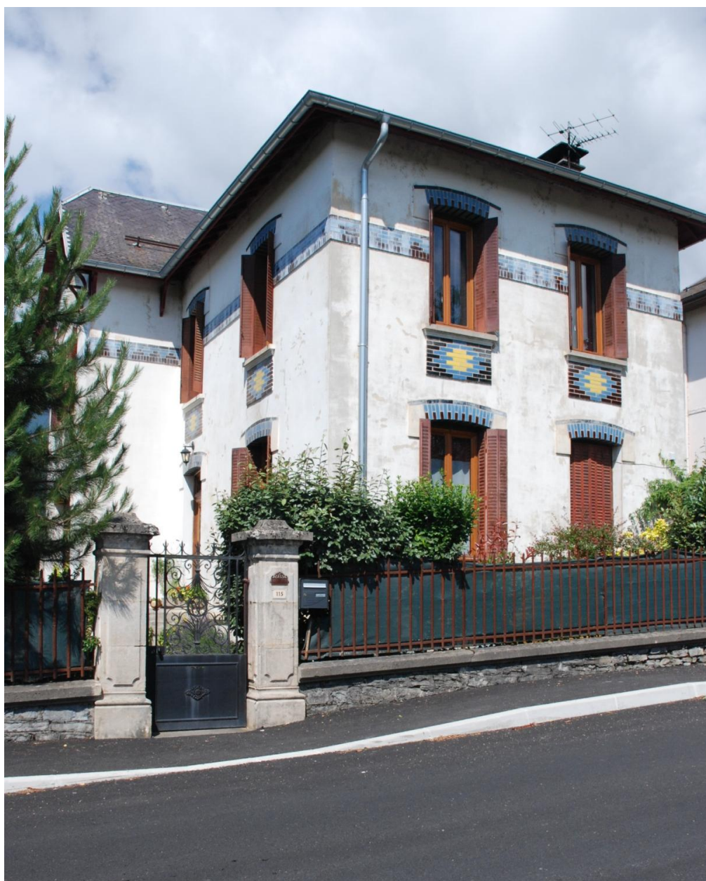
Les villas de l'avenue de la gare : 2018 I 1678.
