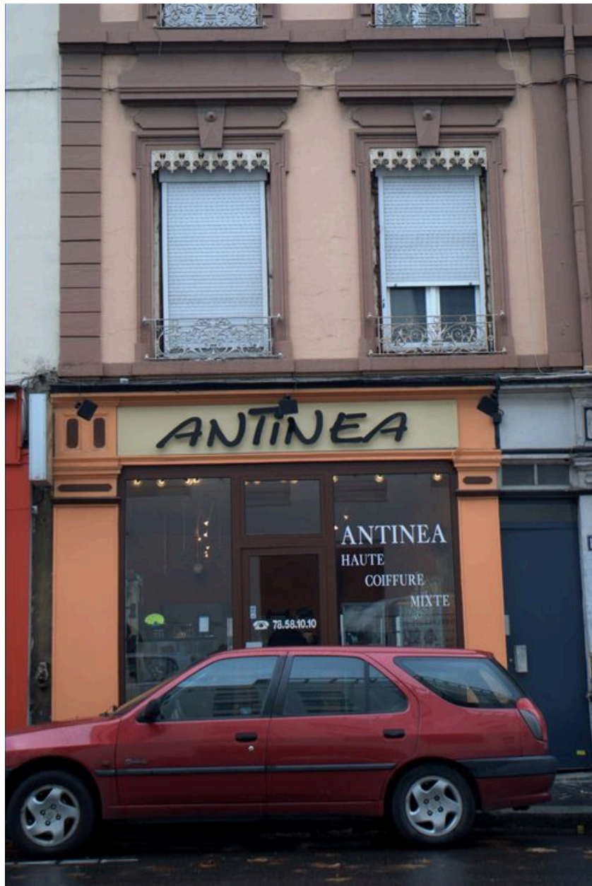
Détail de la modénature de la façade
