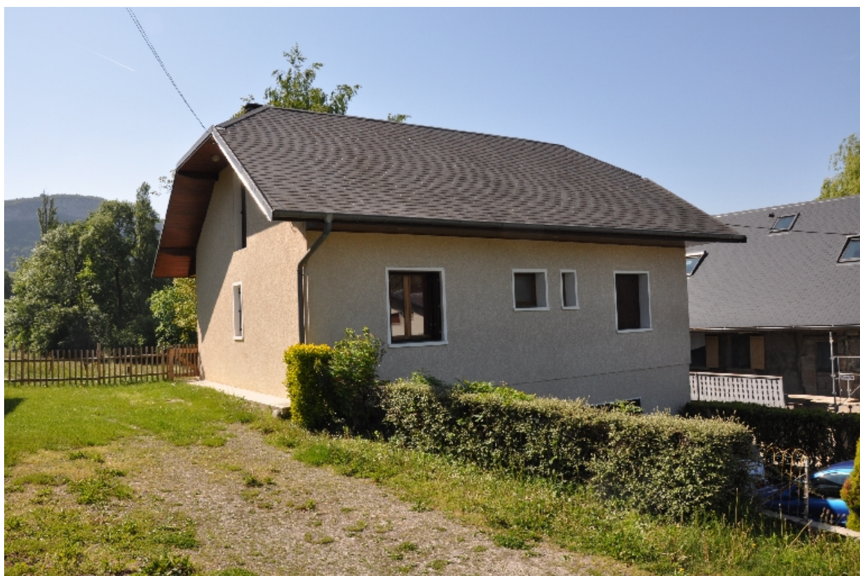
Vue générale du bâtiment remanié du moulin Bizet aval, vue nord-ouest
