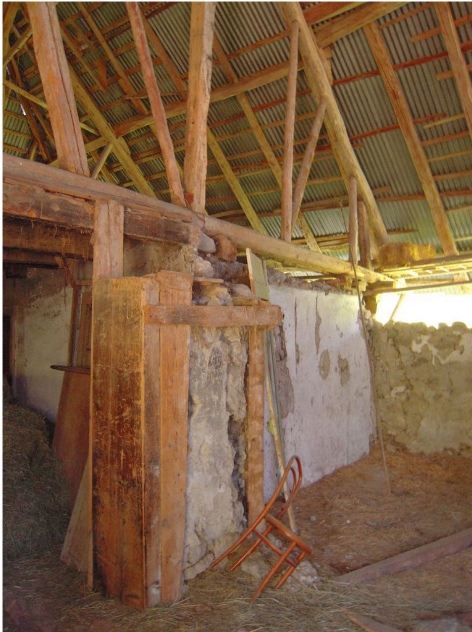
Vue de l'intérieur avec les restes du conduit de cheminée.
