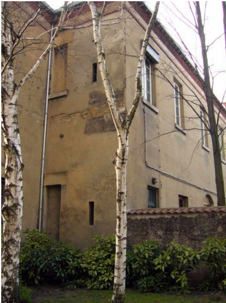
Bâtiment de la galerie, corps de bâtiment est
