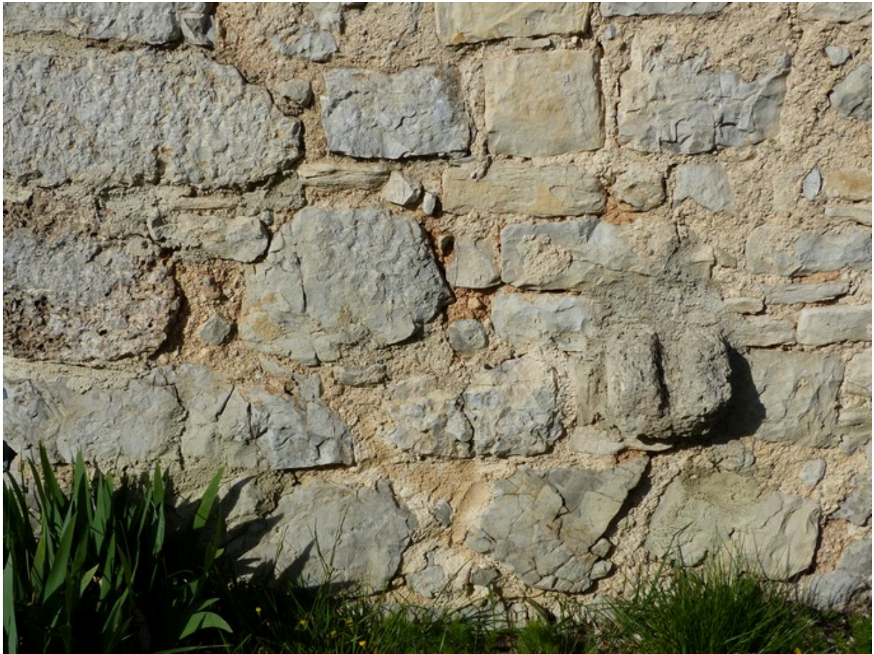
Sortie de pile d'évier en pierre de taille de tuf, ferme à la Clastre.
