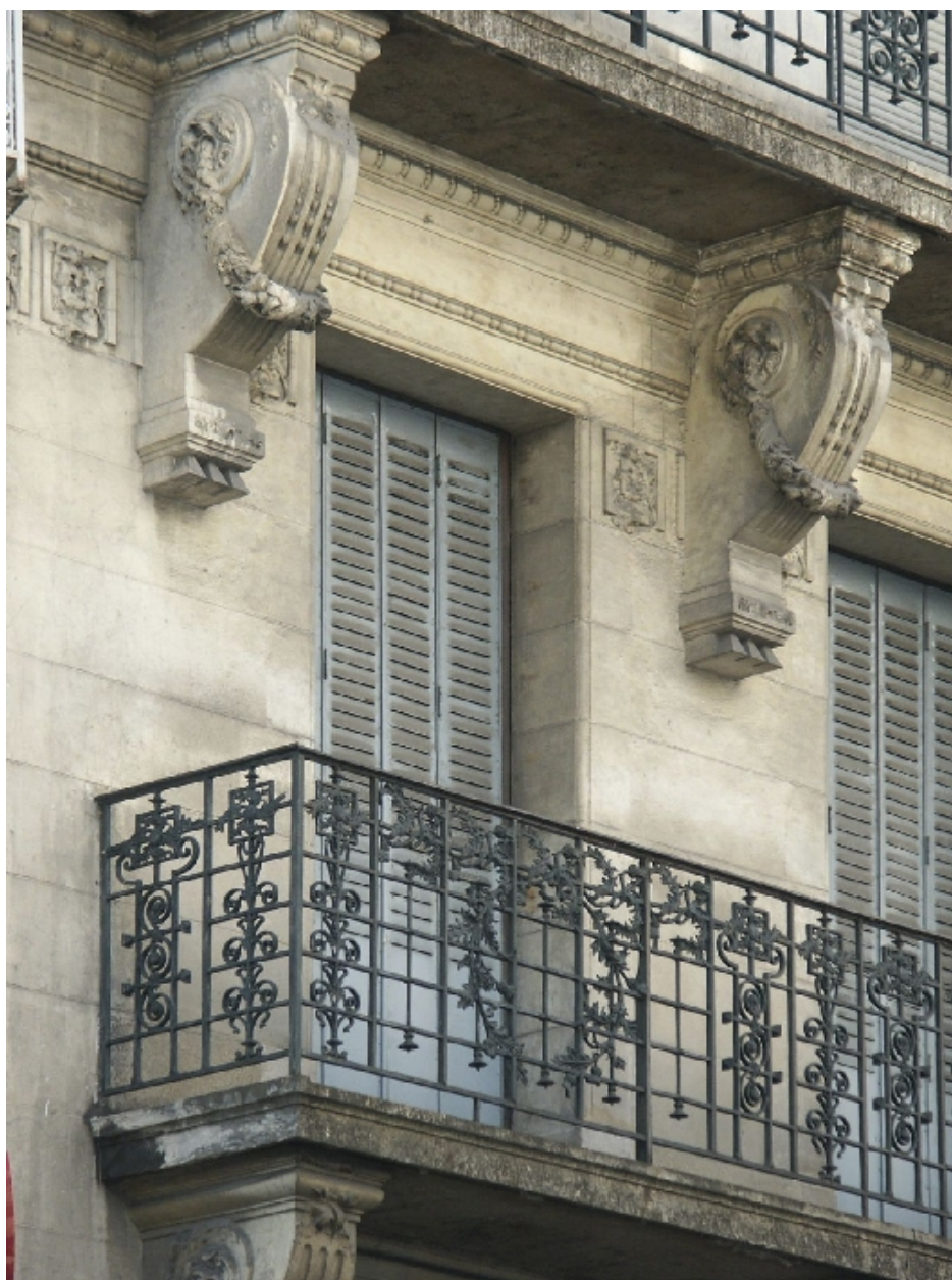
Détail des consoles soutenant les balcons
