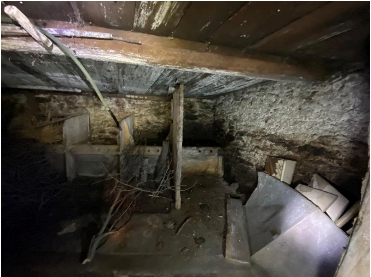
Niveau semi-enterré logis-étable avec crèches et place du mulet.
