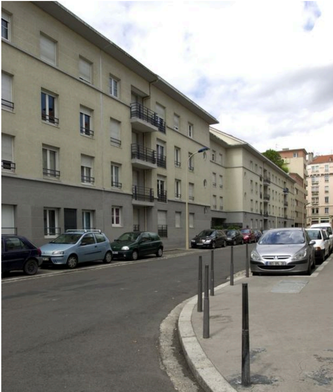
Elévation rue Alphonse-Daudet depuis l'est
