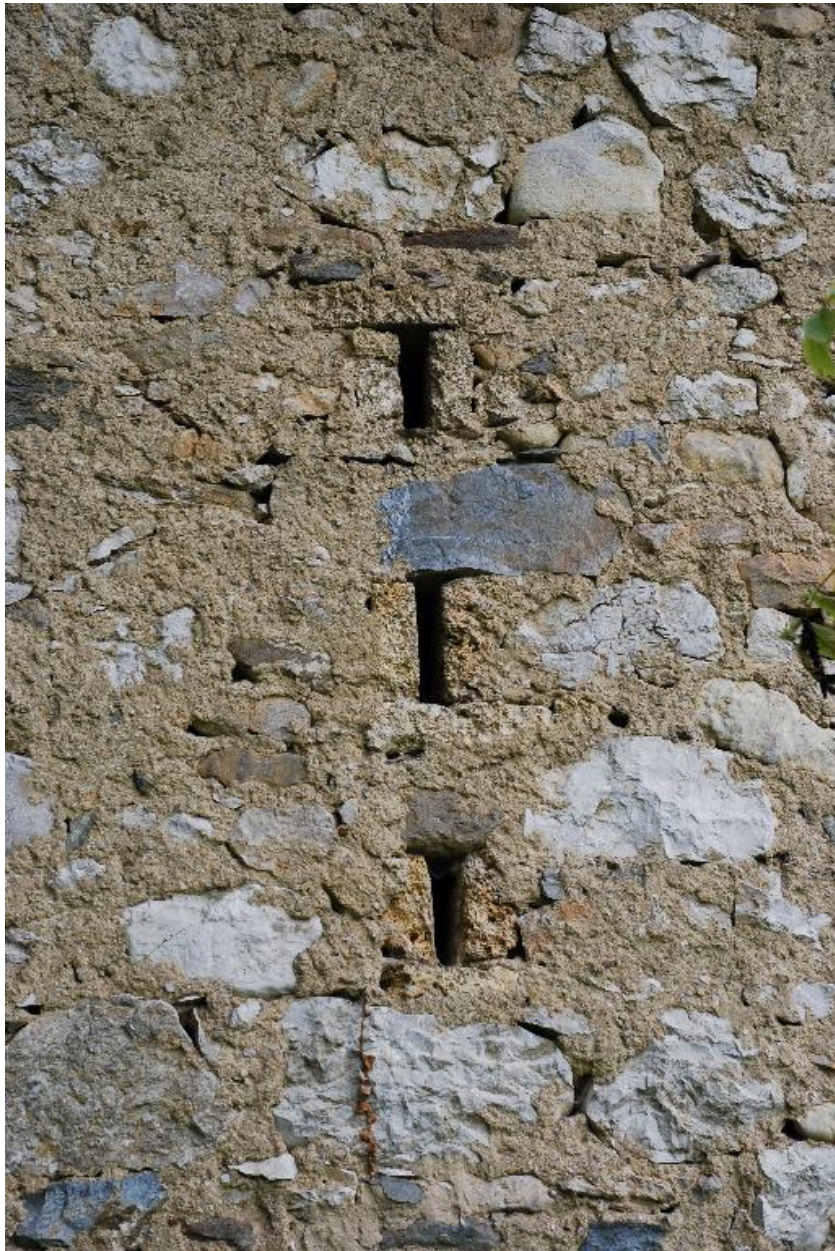
Détail d'ouvertures superposées de placard dans la façade arrière.
