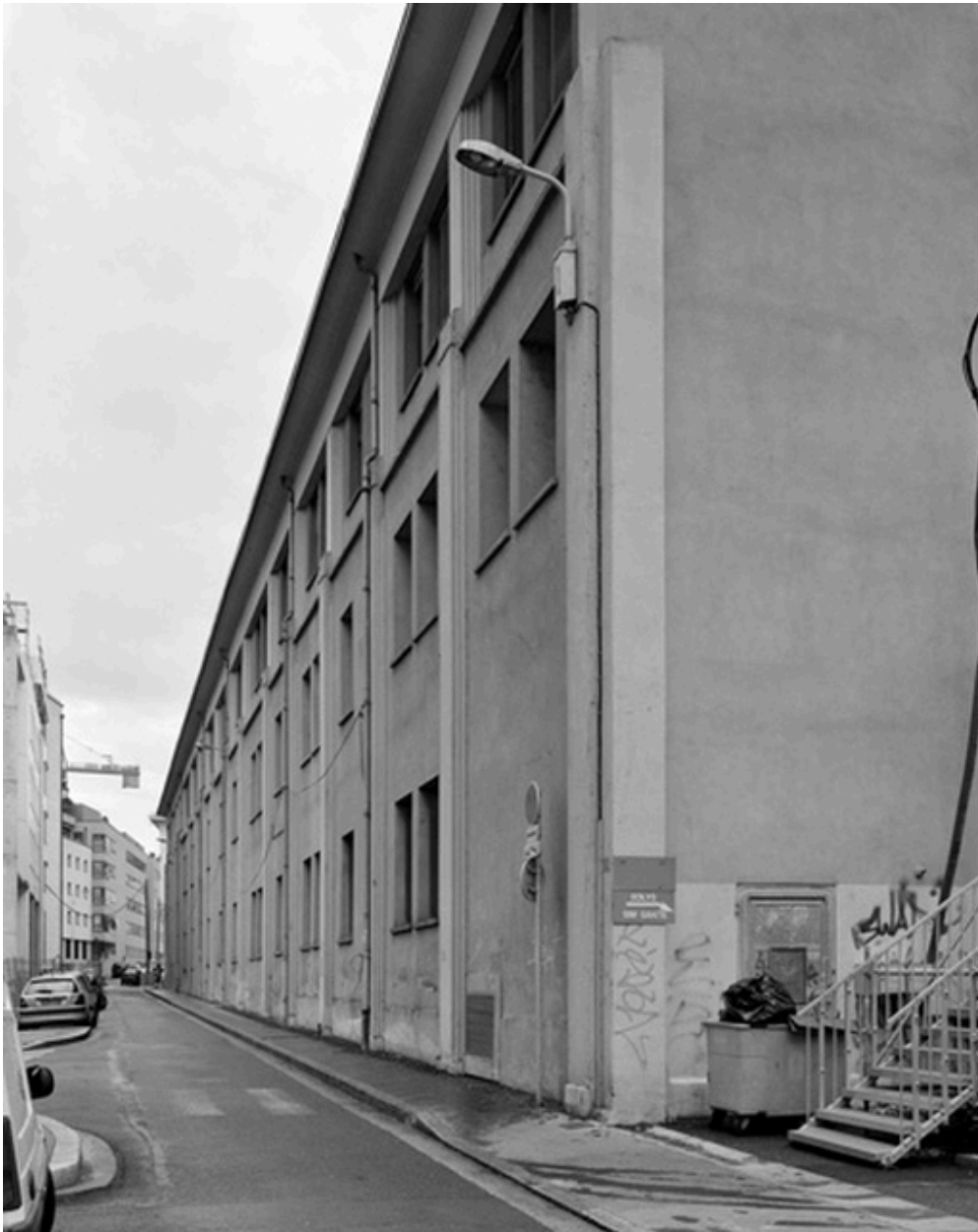
Façade rue de la Grange
