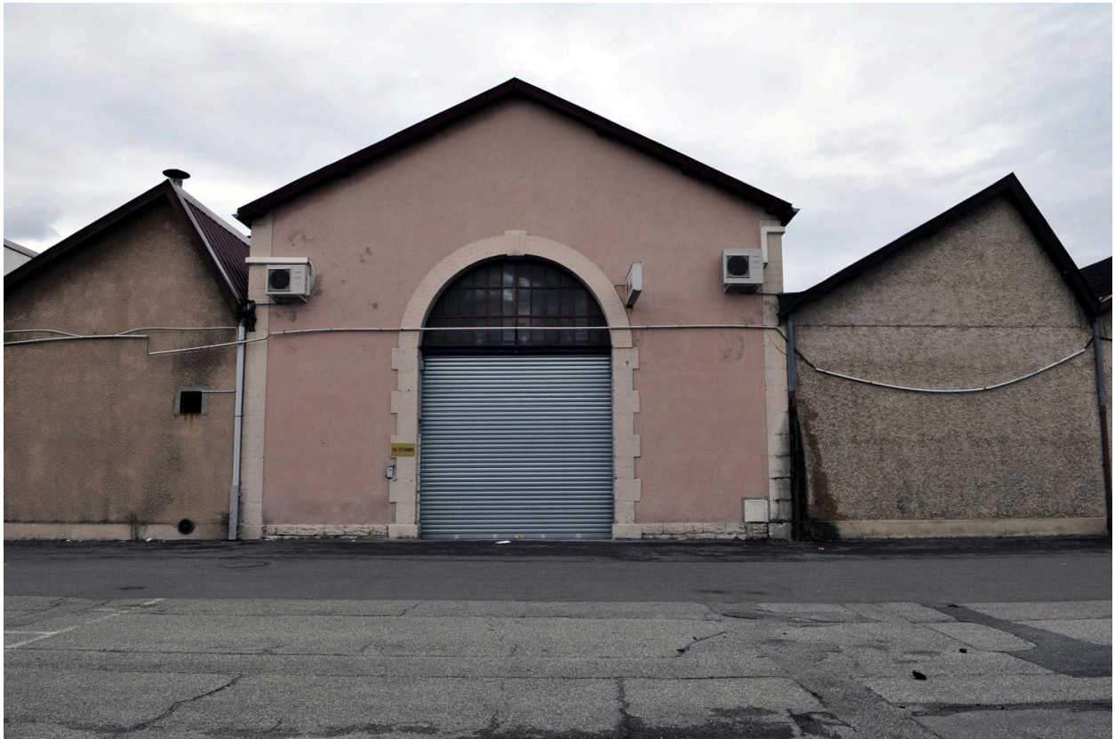
Détail façade de la halle en 2011
