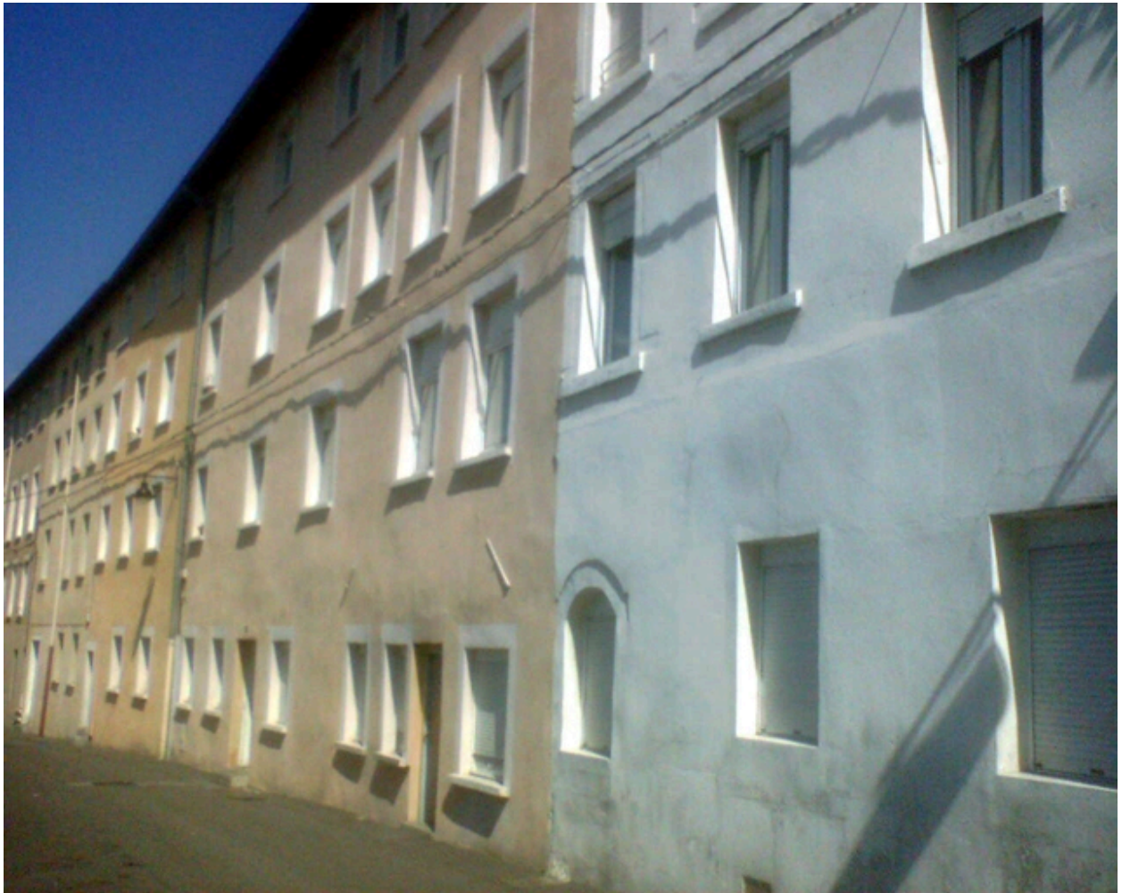
Vue générale sud
