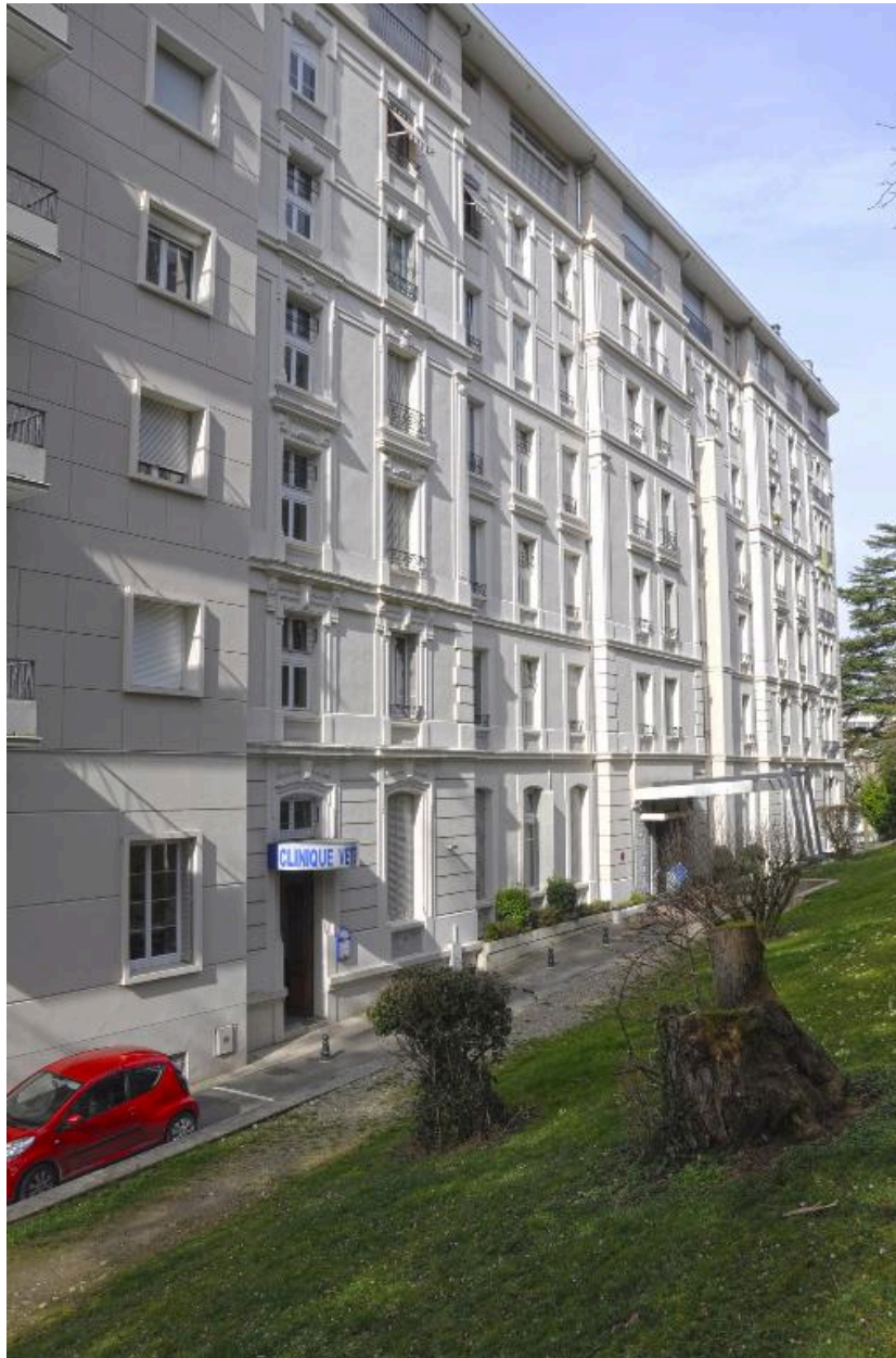
Façade postérieure (est)
