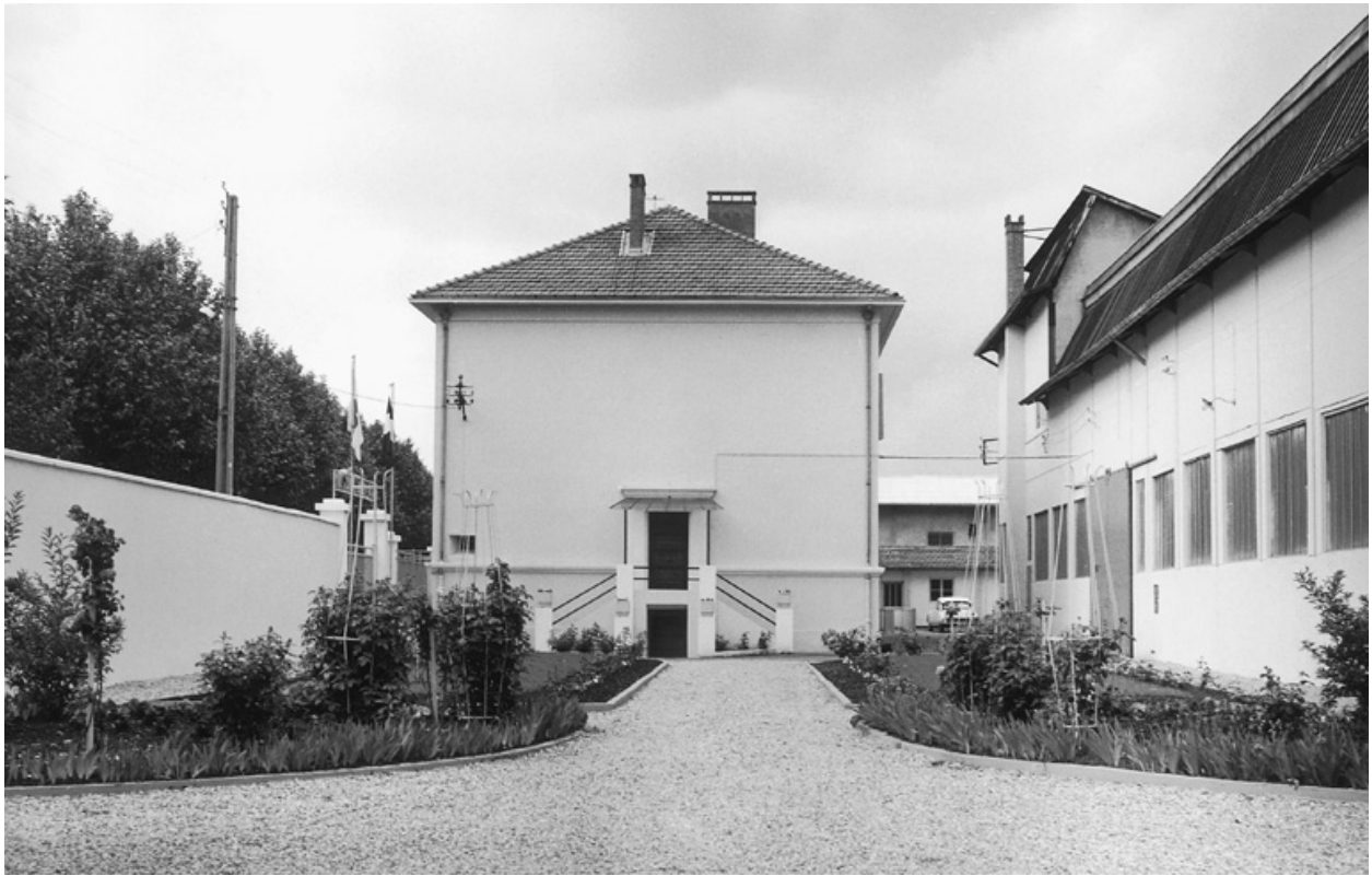
Vue nord cour intérieure, archives privées B. Jouve-Villard
