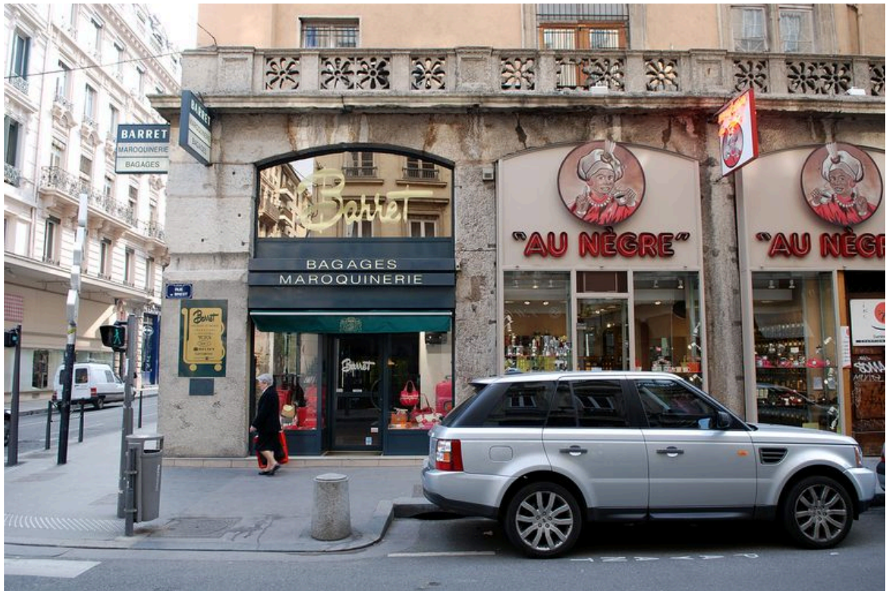
Élévation ouest : arcades et garde-corps de la terrasse
