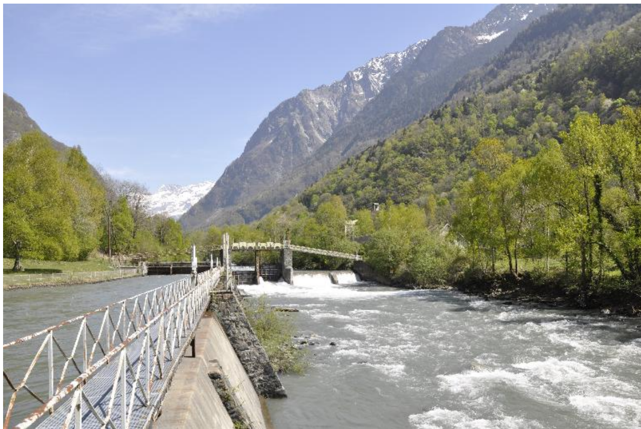
Vue d'ensemble du barrage
