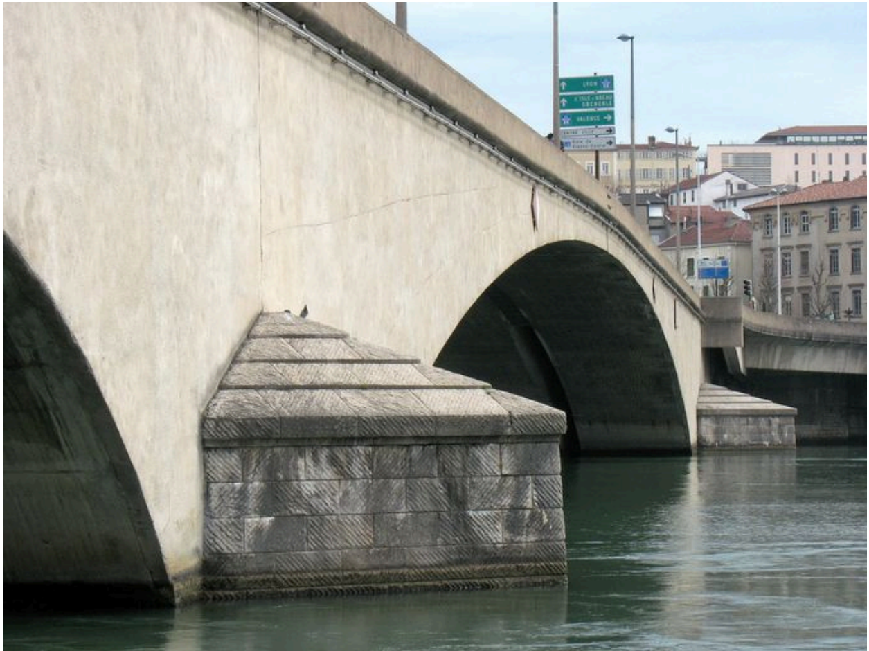
Vue partielle, face aval
