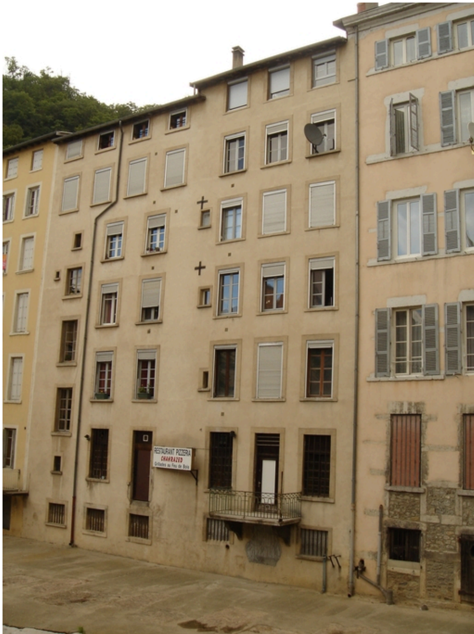
Façade sur Gère
