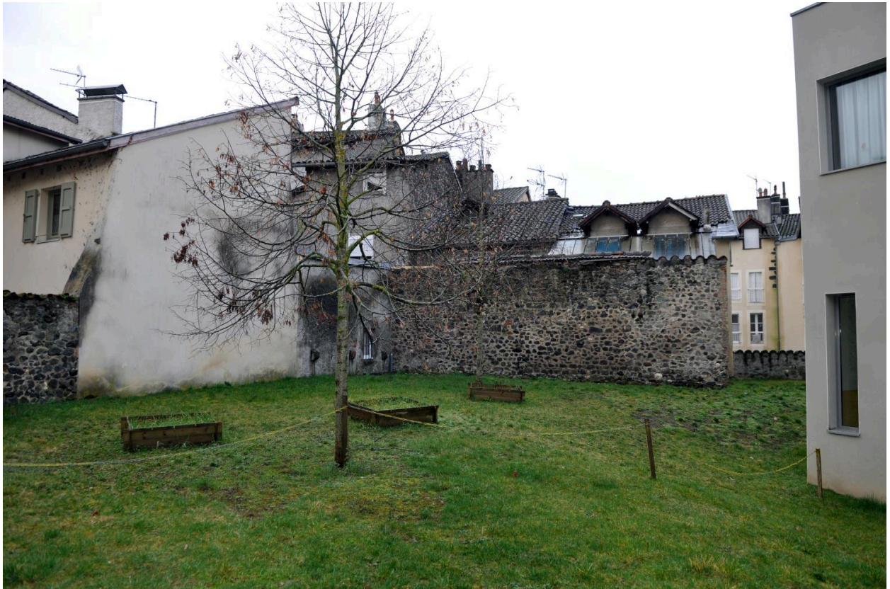
Vestige de l'ancien jardin, mur de clôture côté rue des Fargues
