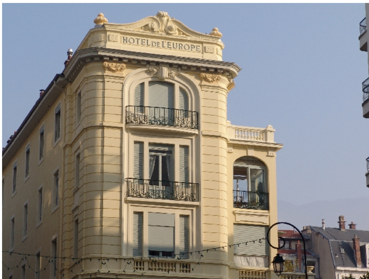
Aile : élévation occidentale
