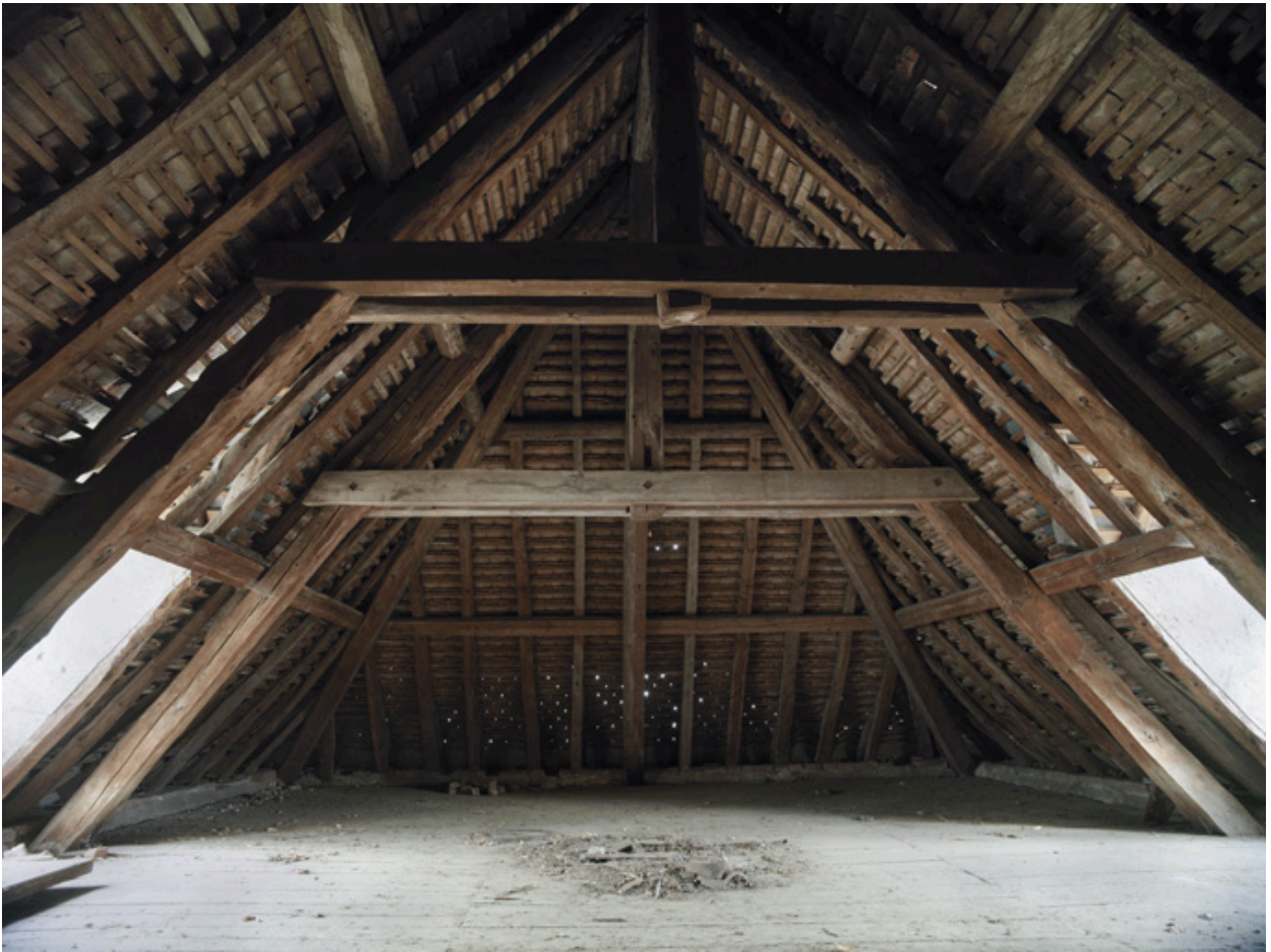
Charpente des communs
