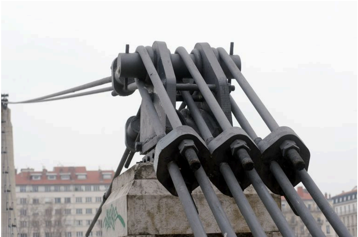
Massif d'ancrage, jeu de câbles (vue partielle)
