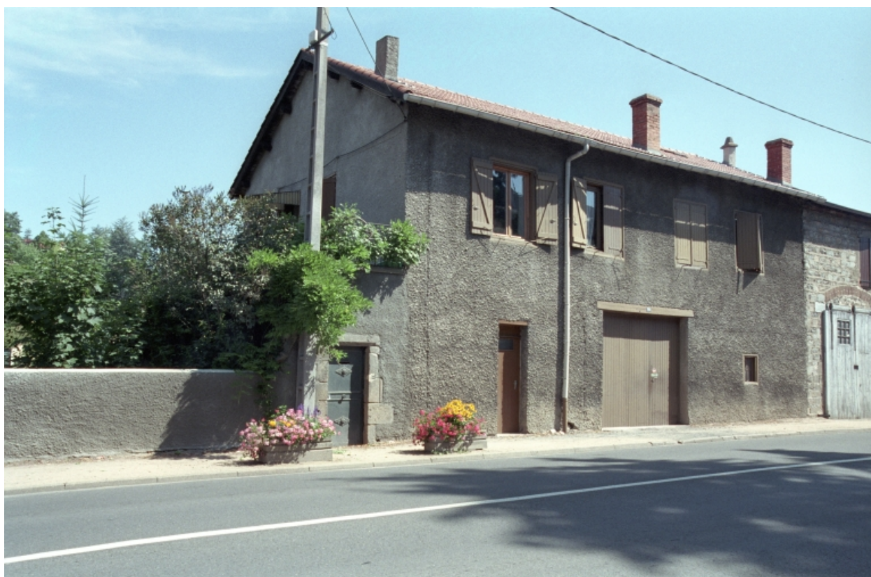
Boën, îlot 11, RN 89, 10. Vue générale de la façade sur rue.
