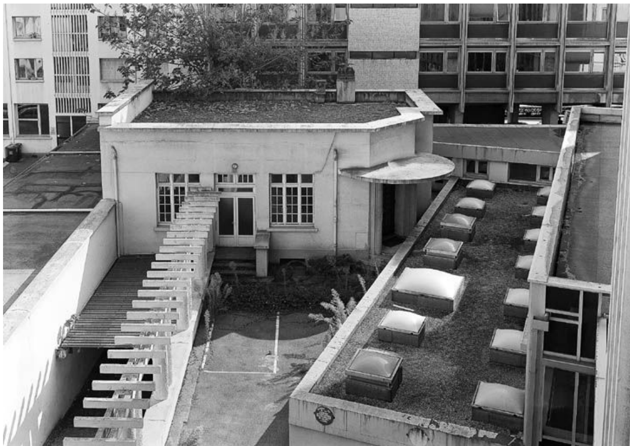
Annexe construite en fond de parcelle et pergola vues depuis le deuxième étage carré
